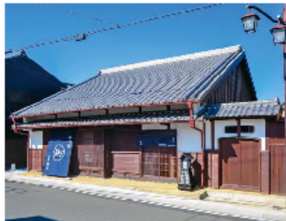
商家「駒屋」外観
